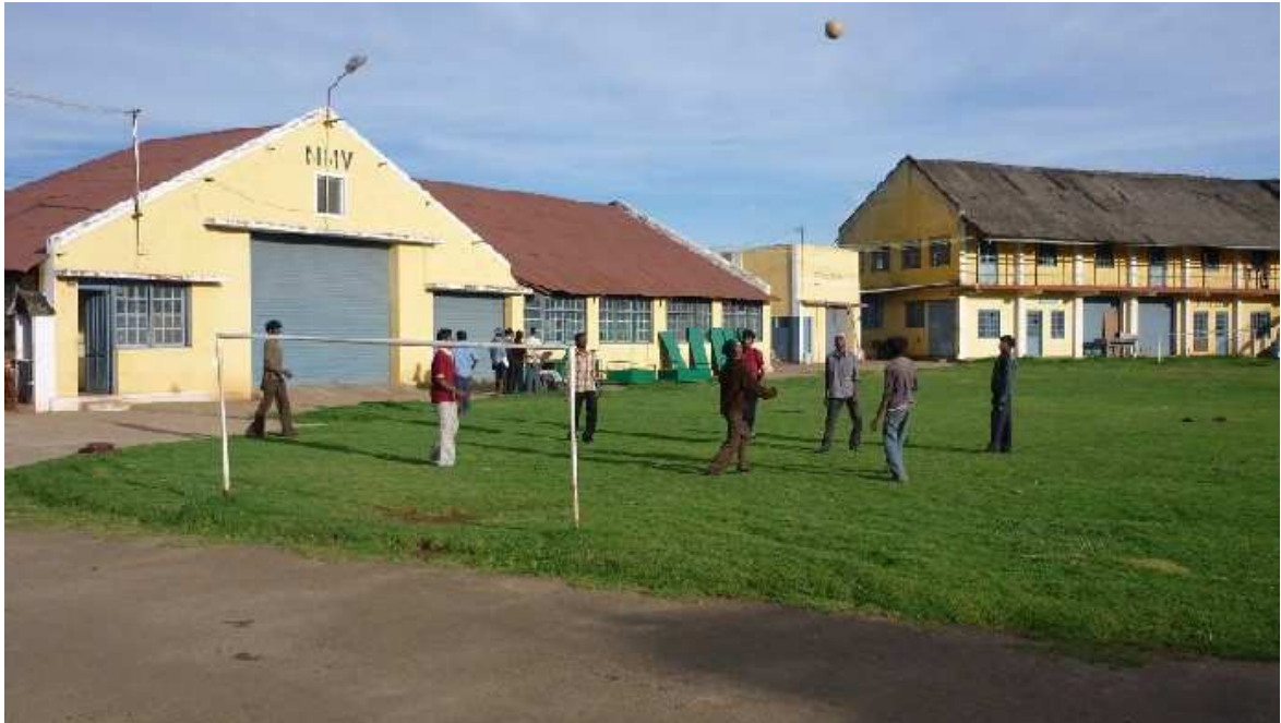
Das Fussballfeld. Der linke Teil des linken Gebaeudes ist das Hostel, der daneben die Schweisserwerkstatt. Im Haus hinten rechts (zur Haelfte im Bild) befinden sich Metallbearbeitung, Fahrschule, Unterrichtsraeume, Musikschule und Speisesaal der Jungs.
